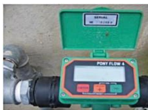
Foto 4: Elektronischer Durchflusszähler (G. Fiaux, 2007)
