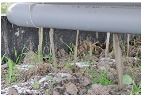
Foto 16: Verteilung über gelochte Leitungen (AGRIDEA)
