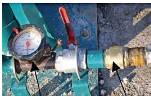
Foto 3: Mechanischer Durchflusszähler mit Anti-Rücklaufventil (G. Fiaux, 2007)
