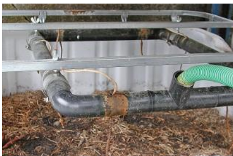
Foto 11: Zufuhr über dem Biofilter (Agrilogie)
