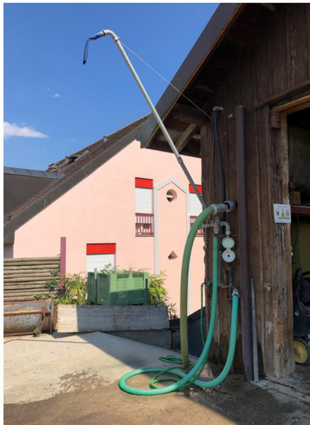
*Der Durchflussmesser verhindert ein Überlaufen, der Schlauchgalgen den Rückfluss der Spritzbrühe.*
